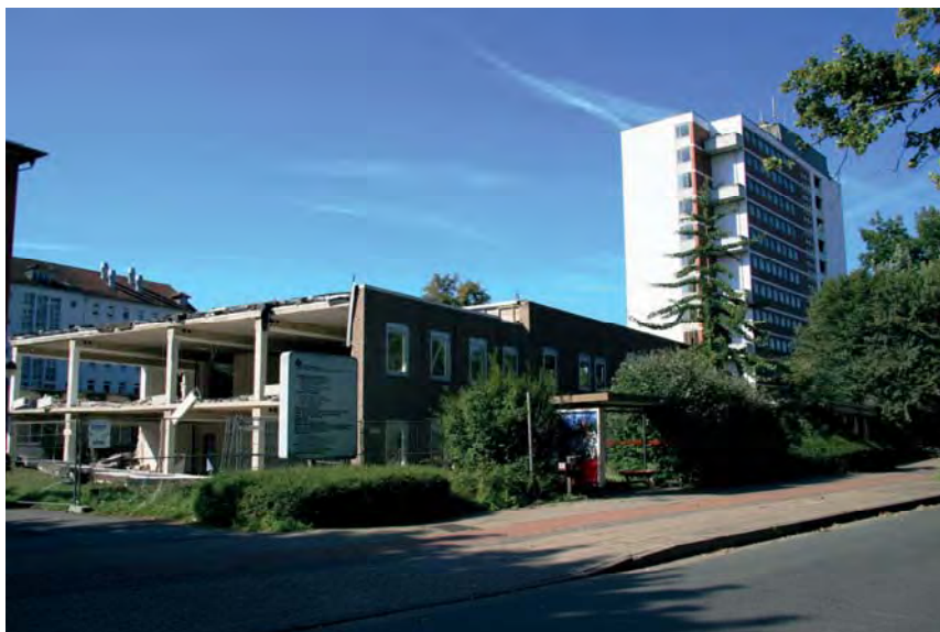
Abrissarbeiten am Klinikum I in Minden, 2008
