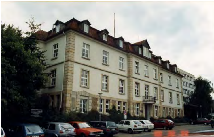
Straßenverkehrsamt im alten Kreishaus Lübbecke
