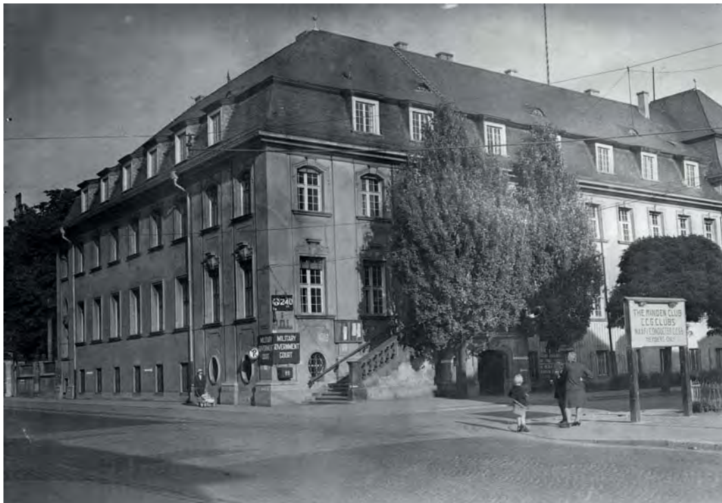
Das Kreishaus Minden an der Ecke Tonhallenstraße / Klausenwall ist Sitz des Military Government Court. KAM, Bildsammlung, A 1 105c.
